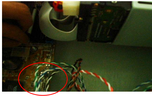
Gambar 2.22 Pemasangan kabel power dan LED
